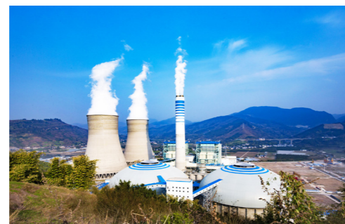
百万机组： 国能重庆万州脱硫除尘超低排放改造项目
