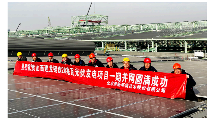
光伏： 山西建龙钢铁 20MW 屋顶分布式光伏发电项目一期工程
