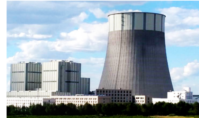
三塔合一： 内蒙古京能盛乐热电有限公司超低排放项目
