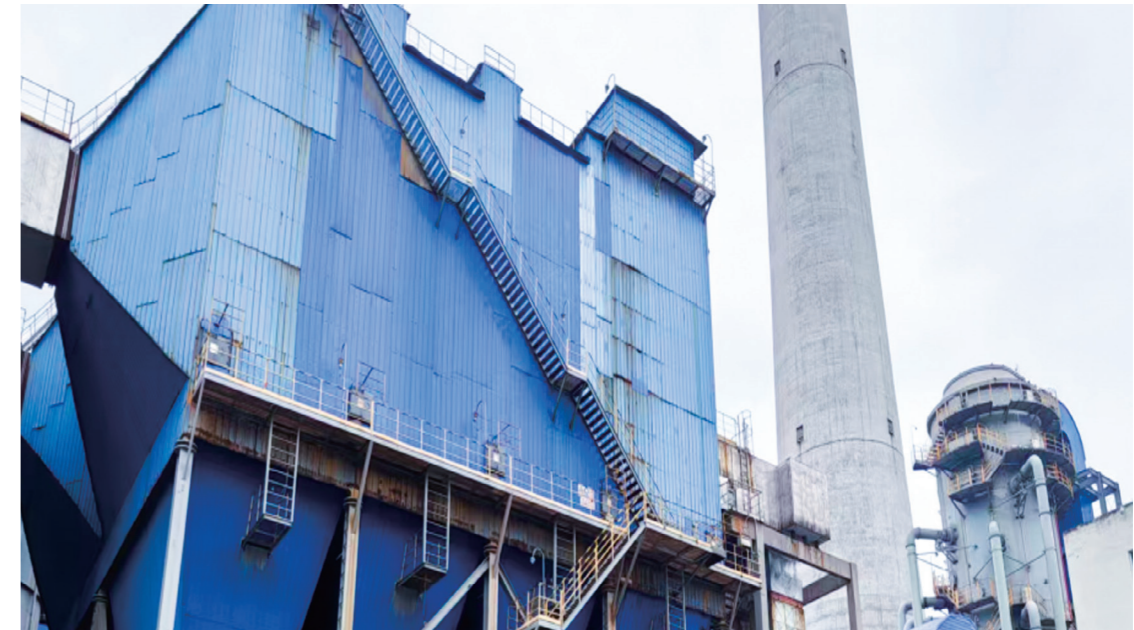
重庆建峰电除尘及脱硫系统超低排放改造项目
